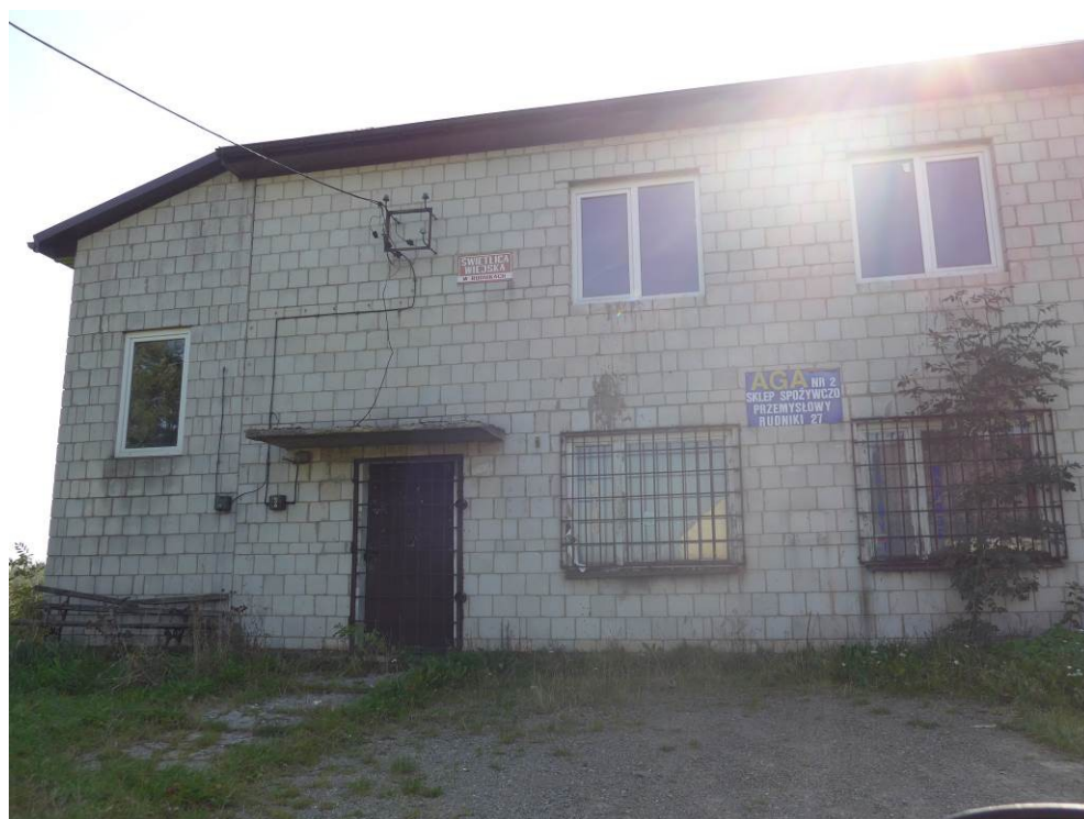
Zdjęcie 15: Świetlica wiejska w Rudnikach listopad 2014r. Foto: GRACZKOWSKI DOTACJE Sp. z o.o.
