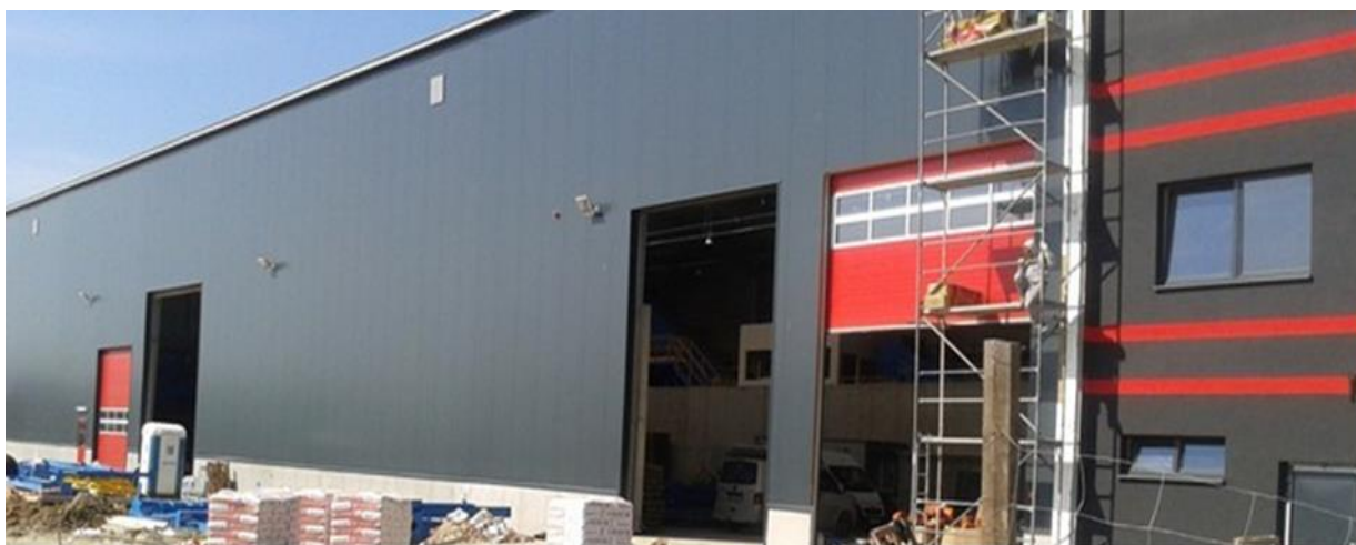
Zdjęcie 3. Zakład Utylizacji Odpadów Komunalnych w Janczycach,
