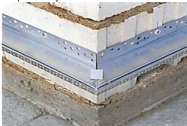
(2) Połączenie listew cokołowych spinką montażową w narożniku
