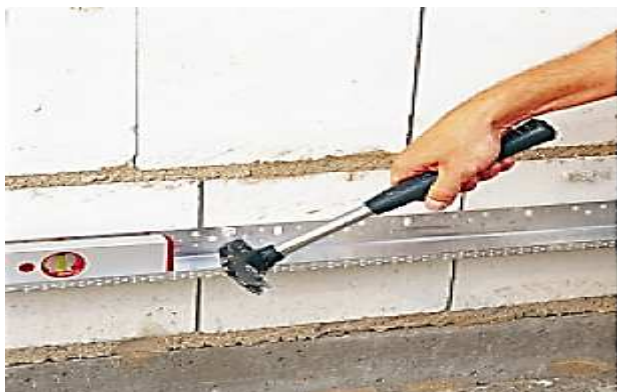
(1) Montaż listwy cokołowej
