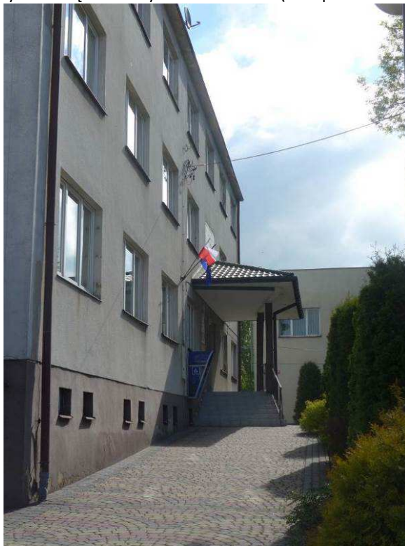
Zdjęcie 26. Budynek Urzędu Gminy w Baćkowicach (stan przez termomodernizacją)
