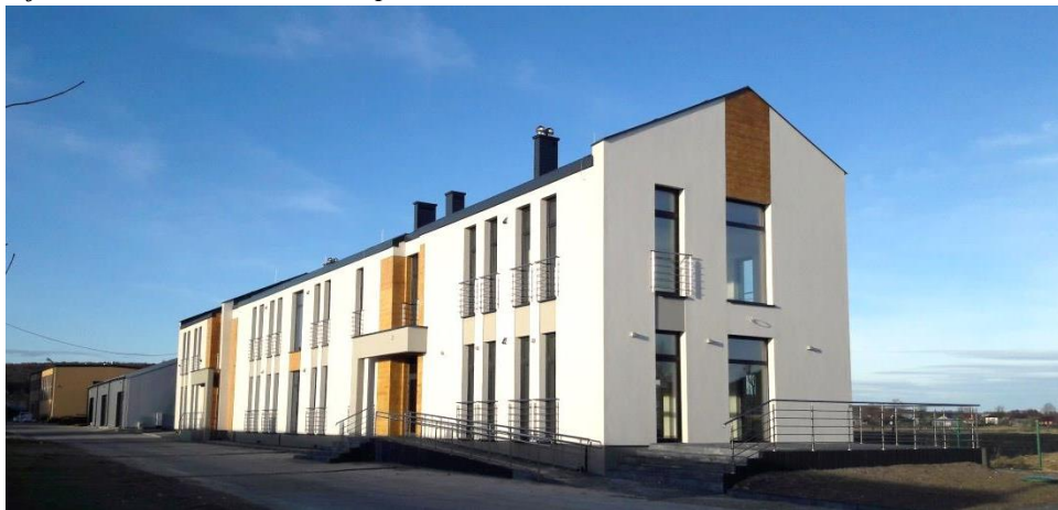
Budynek usługowo-handlowy (segment II)
