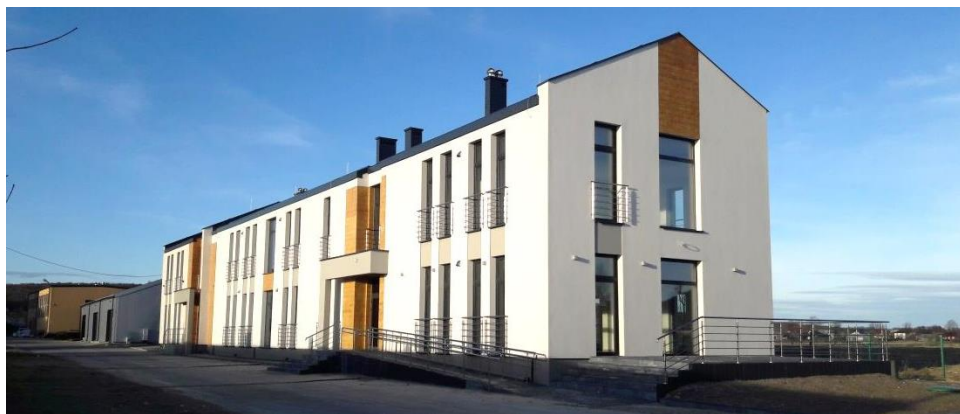
Budynek usługowo-handlowy (segment II)
