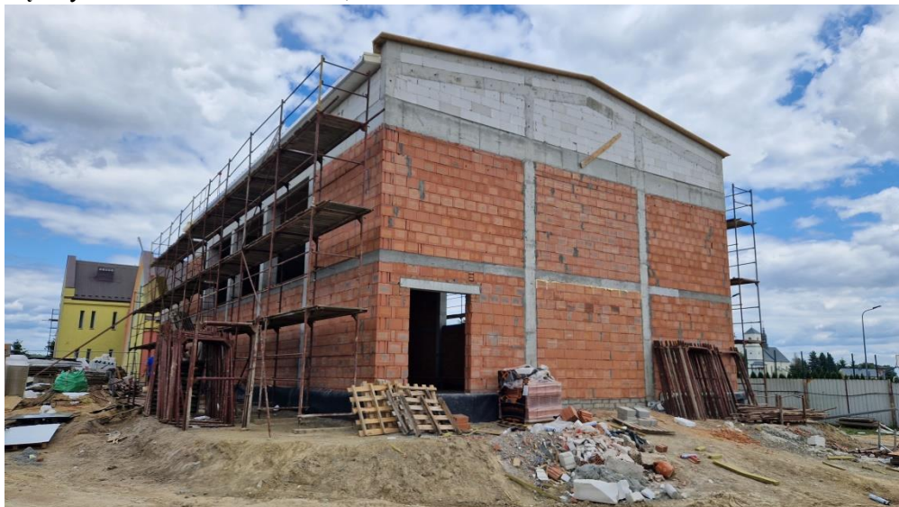
Modliborzycze: budowa Sali gimnastycznej
