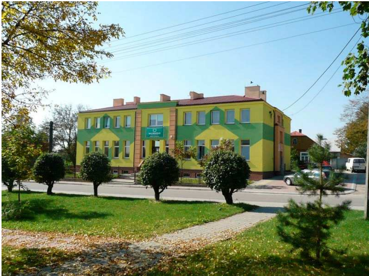
Fot. Dawny budynek Kasy Stefczyka, obecnie Bank Spółdzielczy w Baćkowicach (fot. W. Frejlich)
